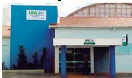
Construção de Unidades de Pronto Atendimento.
