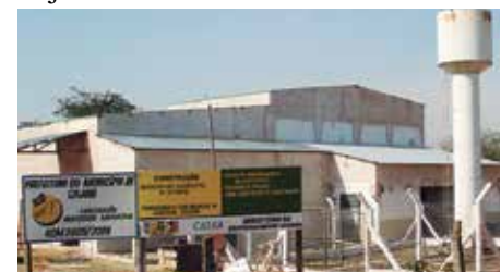
Construção do Abatedouro Assis Mentor, em Cajobi.
